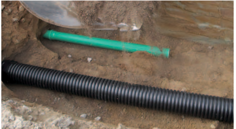
KG 2000 (acqua di scarico) e X-Stream (acqua piovana) in condutture separate
