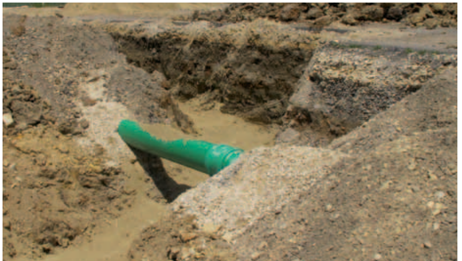
Incroccio di condutture per un risanamento sostenibile: nessun problema
